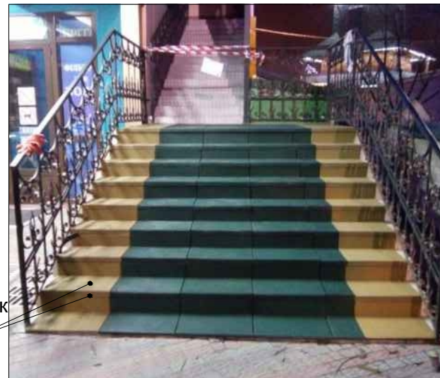
Пример покрытия лестниц из резиновой плитки
