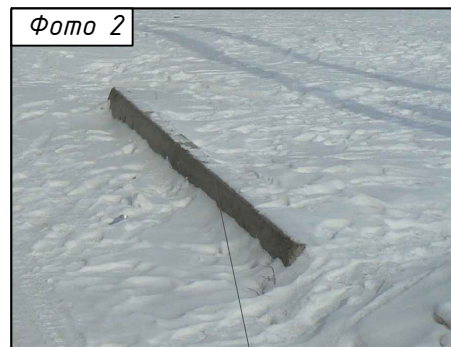
Демонтаж бордюрного камня
